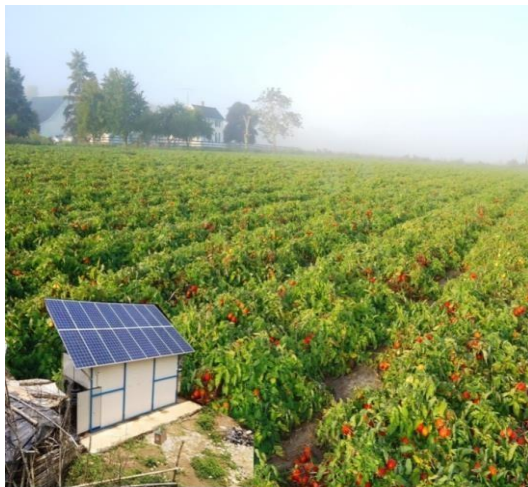
Fig. 6 Mini Cold storage with Solar Panel
